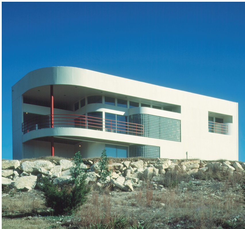
Siding-Platten mit eingefrästen Nuten und rau-gesägter Oberfläche, deckend gestrichen. (Bei 12 mm Plattendicke sind quer zum Faserverlauf der Deckfurniere Biegeradien von 1,80 m, bei 15 mm Plattendicke immerhin noch bis 2,44 m möglich.)
